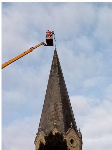
Mise en conformité du paratonnerre de l'Eglise
